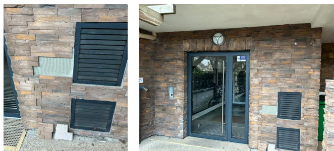
Décollements observés en façade suite à un défaut de collage.
